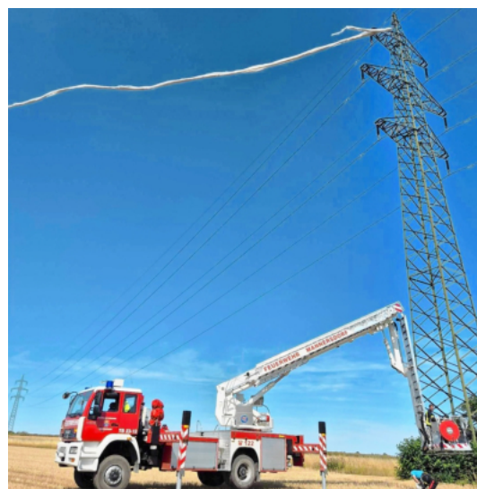
◀ Die Plastikfolie wurde mit Hilfe der Feuerwehr aus der Stromleitung geholt.
