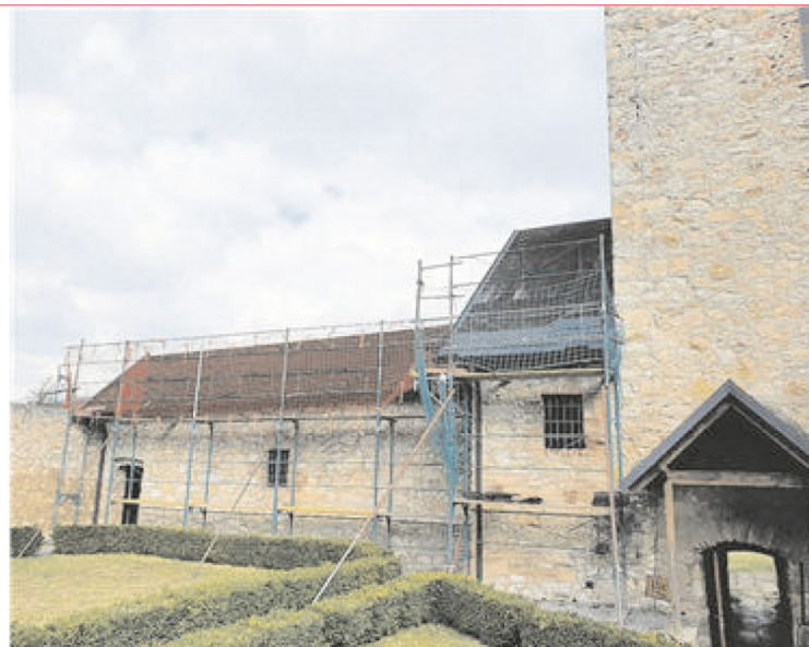
▲ Das Dach vom Eingangsbereich des Klosters wird derzeit neu eingedeckt. Foto: privat
