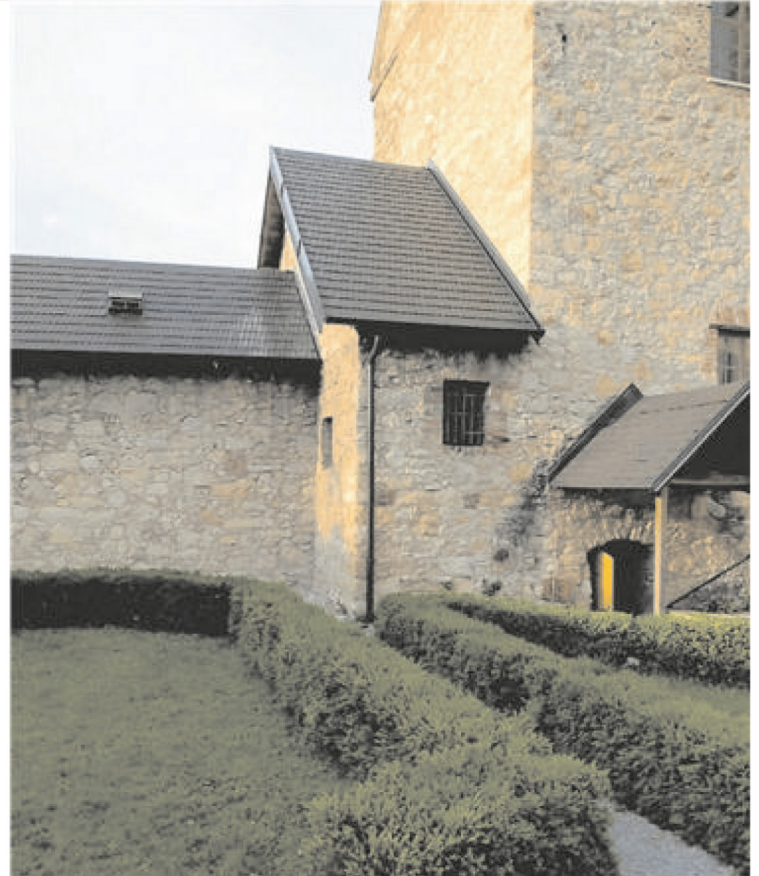
▲ Das Dach wurde fertiggestellt, neu gedeckt und mit Dachrinnen versehen. Fotos: Sandra Karanitsch-Ackerl
