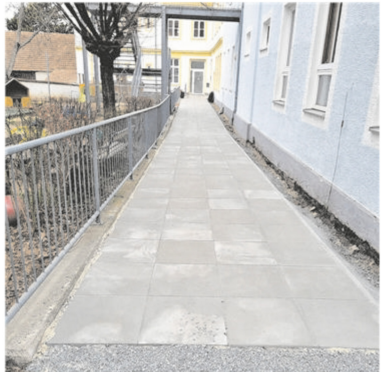
▲ Im Hof wird derzeit am Weg zum Eingang zur Kleinkinderbetreuung gearbeitet, um einen barrierefreien Zugang zu ermöglichen.
