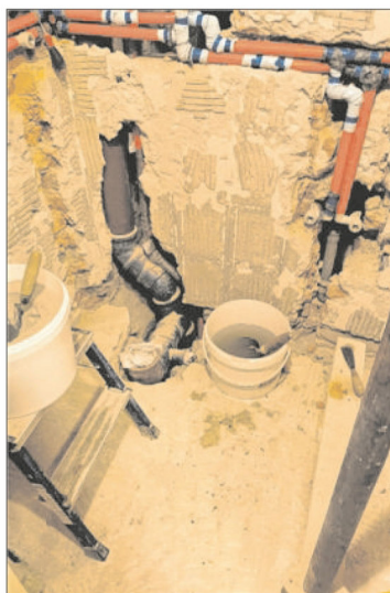
Duschen und Toiletten der Mieter wurden entfernt. Fotos: privat
