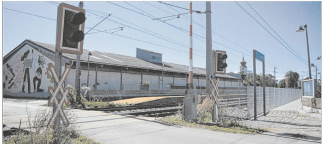
Die drei Eisenbahnkreuzungen in Trautmannsdorf werden während der Erneuerung der Gleise temporär gesperrt. Ein Übergang soll jedoch immer offen bleiben.
