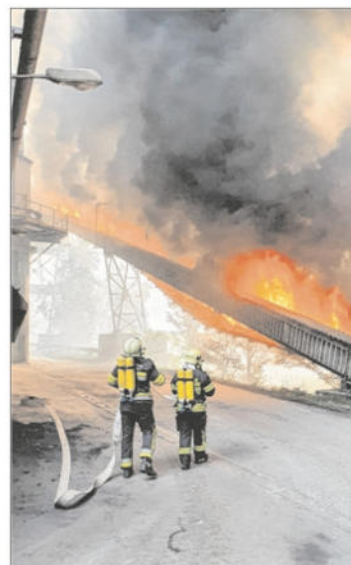
Der Brand im Zementwerk soll durch Selbstentzündung ausgelöst worden sein. Foto: FF Mannersdorf
