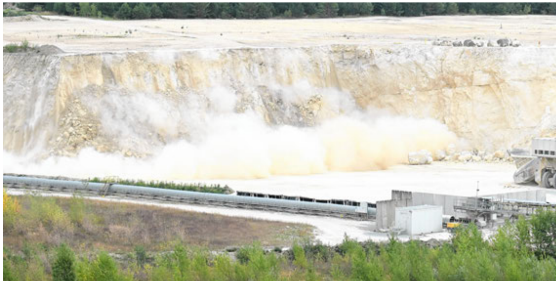
▲ Drei Mal lud das Holcim-Zementwerk zu Schausprengungen in den Steinbruch Mannersdorf. Fotos: Holcim Österreich/Sommerauer
